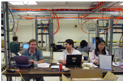
Hot-staging at UNH-IOL (Durham, NH)
